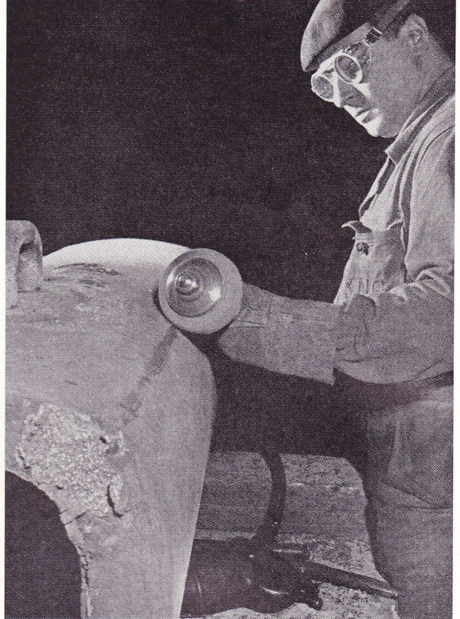
Een gietstuk wordt bijgeslepen
